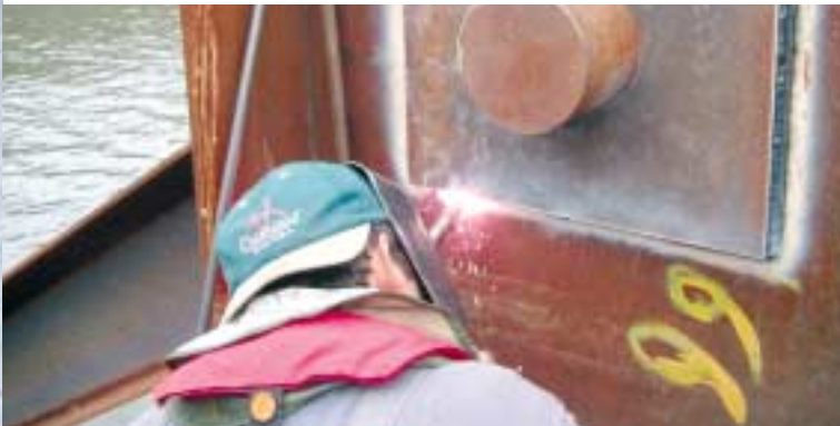
◀ Anschweißen der Tragbohlen- platte in Pos. PD
