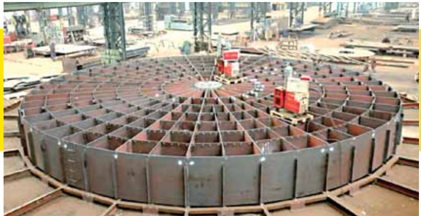
5. Fertigungsschweißung an einem Gasvorwärmerrotor
