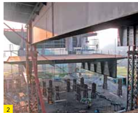
Das Segment wird in die Brücke gehoben.
