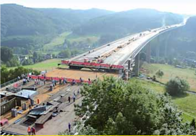
Wiehltalbrücke – mit High-Tech repariert
