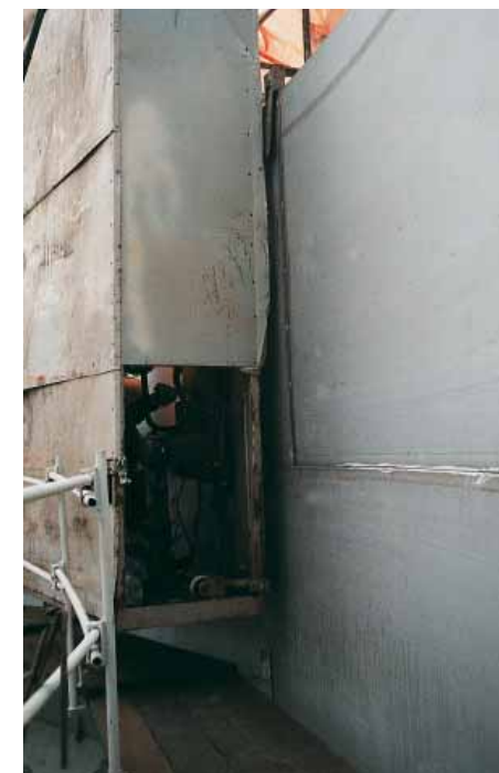
Bild 2: ESAB A6 Circomaster beim Schweißen der ersten Lage (innen)
