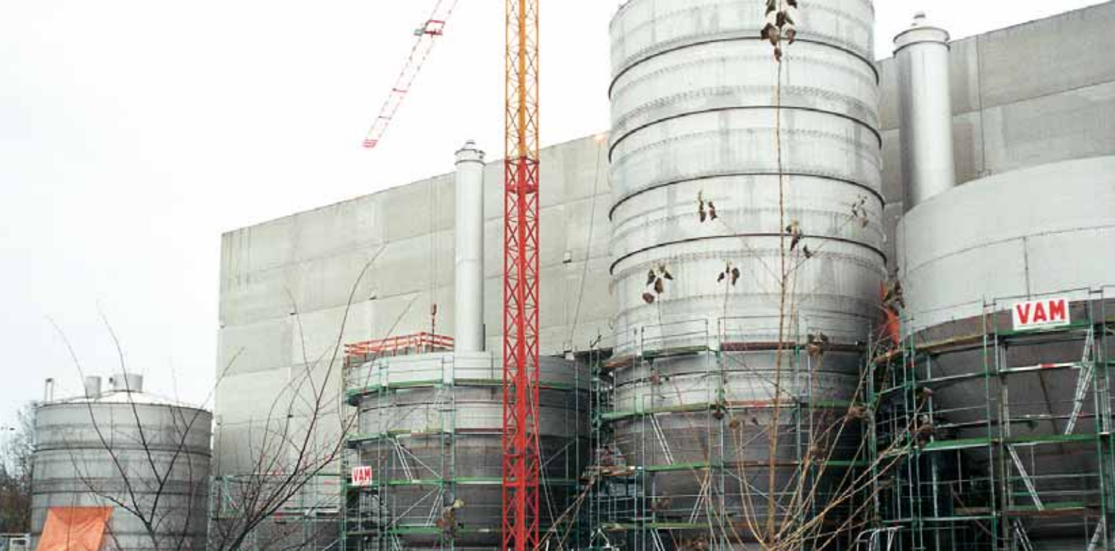
Bild 1: Tankbaustelle. Links: Oberes Tanksegment in Hubbauweise auf separatem Bauplatz
