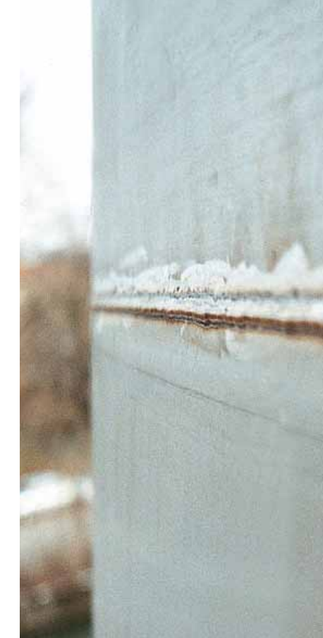
Bild 5: Fertiggestellte UP-Quernaht
